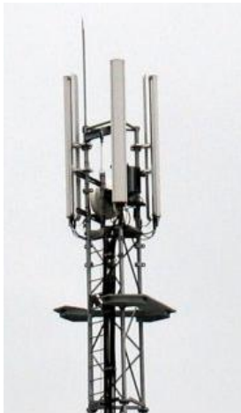
Les 3 antennes d'un relais émetteur
